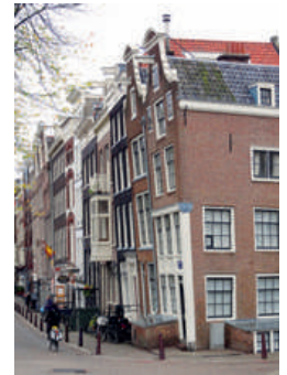
La Maison Penchée
